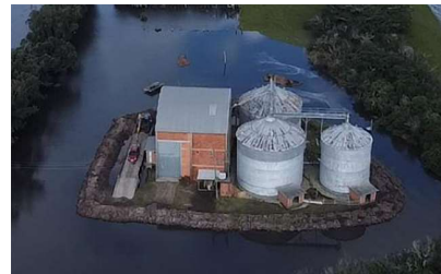
Criação de barreiras físicas de contenção, para proteção de silos
